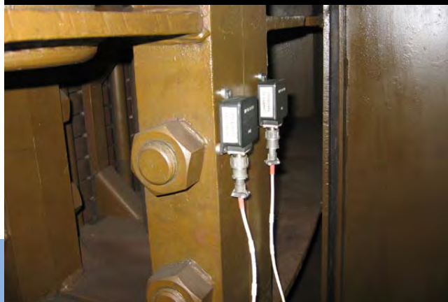
Датчик вибрации стыков секторов статора генератора
